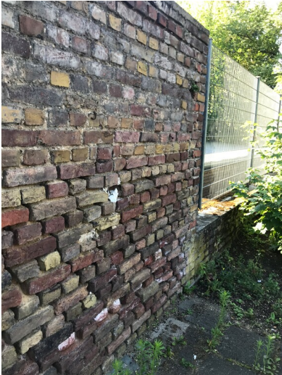
Östliche Fassade Fabrikhalle Dorn (2022) Fotograf/Urheber: Nicole Schmitz
