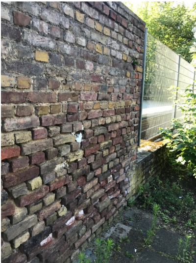
Östliche Fassade Fabrikhalle Dorn (2022) Fotograf/Urheber: Nicole Schmitz
