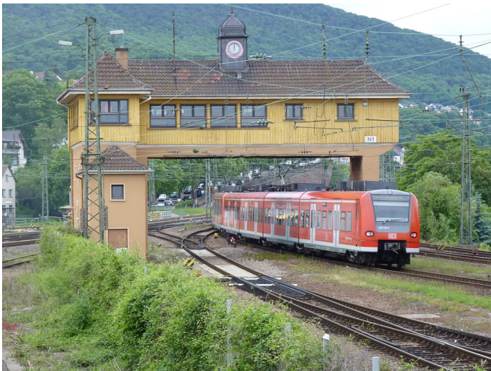
Gebäudeansicht Stellwerk Nf mit S-Bahn (30.05.2014) Fotograf/Urheber: Sammlung Reiner Frank
