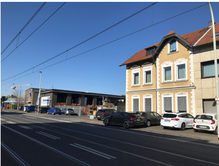
Das repräsentative Wohnhaus an der Kölner Straße war Wohnhaus und zugleich Verwaltungsgebäude der Baumaterialienhandlung und Dachziegelfabrikation der Familie Cremer. (2020) Fotograf/Urheber: Nicole Schmitz
