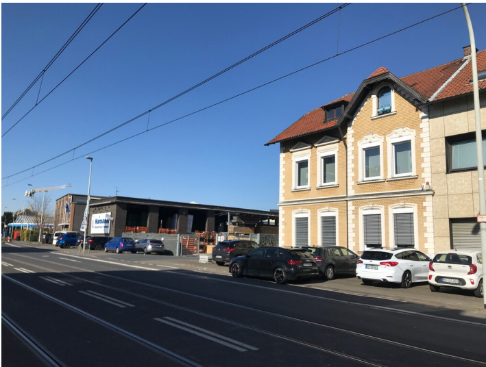
Das repräsentative Wohnhaus an der Kölner Straße war Wohnhaus und zugleich Verwaltungsgebäude der Baumaterialienhandlung und Dachziegelfabrikation der Familie Cremer. (2020) Fotograf/Urheber: Nicole Schmitz
