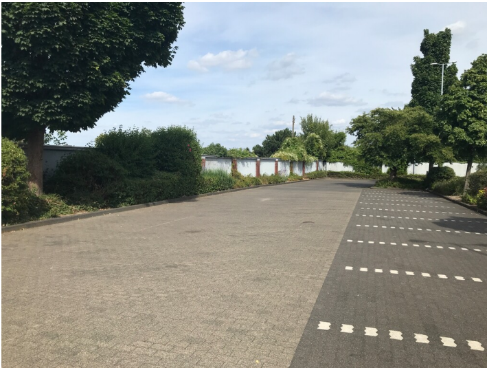
Lärmschutzwand des Steinzeugwerkes Rhenania (2022) Fotograf/Urheber: Nicole Schmitz
