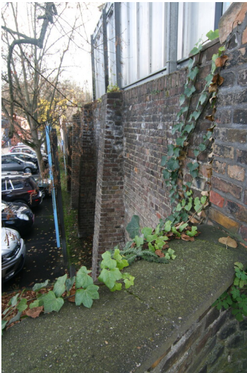
Stützmauer an der Villa Vogt zum Grundstück der Steinzeugfabrik Rhenania (2021) Fotograf/Urheber: Nicole Schmitz
