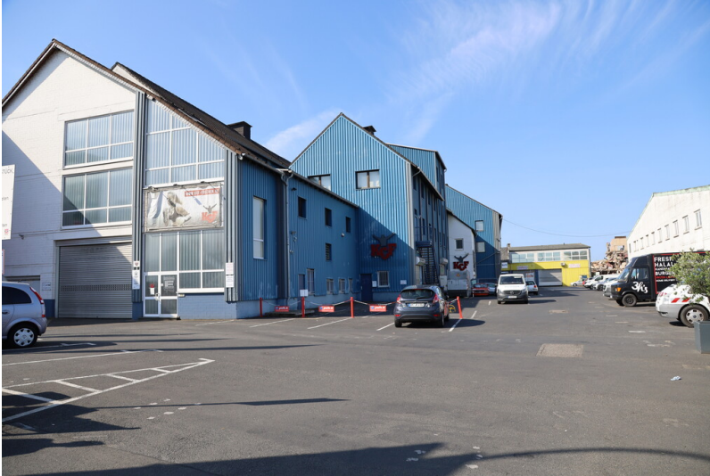
Fabrikhallen der ehemaligen Steinzeugfabrik Josef Conzen & Cie. (2024) Fotograf/Urheber: Nicole Schmitz
