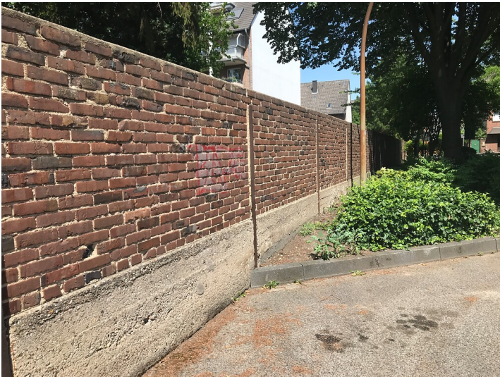
Westliche Grundstücksmauer der ehemaligen Steinzeugfabrik Lövenich & Hendrickx in Frechen (2022) Fotograf/Urheber: Nicole Schmitz
