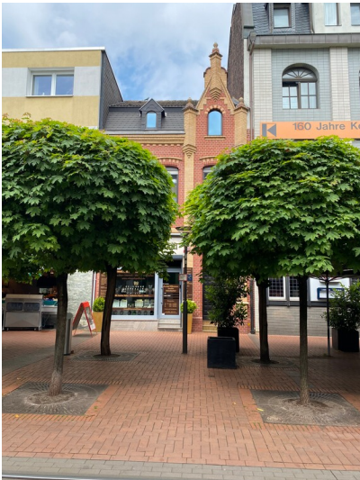
Fabrikantenwohnhaus Andreas Lövenich (2023) Fotograf/Urheber: Nicole Schmitz
