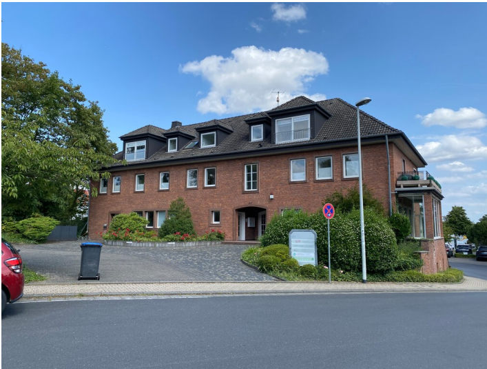
Verwaltungsgebäude des Steinzeugwerkes Grosspeter-Lindemann (2024) Fotograf/Urheber: Nicole Schmitz
