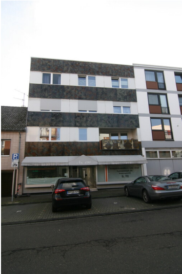
Wohn- und Geschäftshaus mit braun-grau-schwarzer KerAion-Fassade in Frechen (2021) Fotograf/Urheber: Nicole Schmitz
