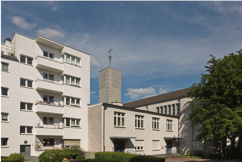
Die Katholische Pfarrkirche St. Petrus Canisius in der Siedlung Weiße Stadt in Köln-Buchforst (2017) Fotograf/Urheber: Viola Blumrich
