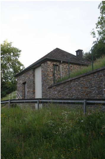
Der Wasserhochbehälter auf dem Zillesberg bei Treis (2022) Fotograf/Urheber: Klaus Layendecker
