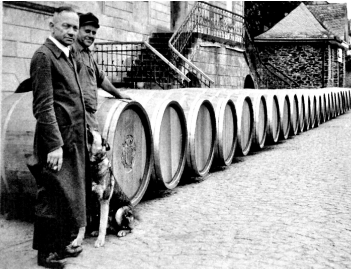
Ehemalige Fasseichstelle in Briedel Fotograf/Urheber: Archiv Hermann Thur
