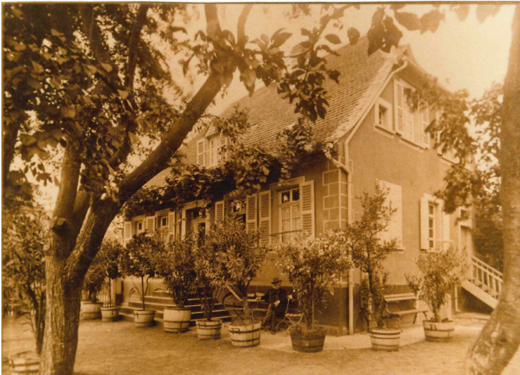
Sommerhaus Georg von Neumayers in Weisenheim am Berg Fotograf/Urheber: Privatchiv Bernd Wehrum
