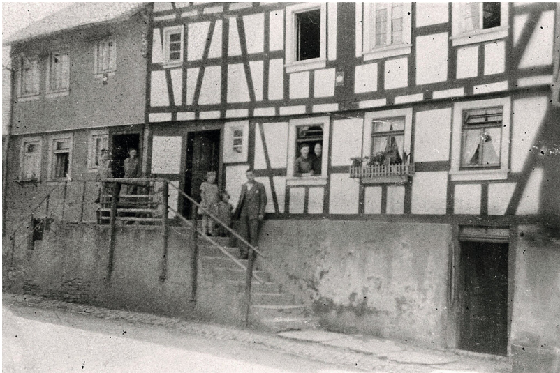
Ehemaliges katholisches Schulhaus in Weisel Fotograf/Urheber: Forschungsgruppe Weiseler Geschichte(n)
