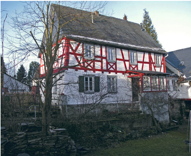
Ehemaliges evangelisches Schulhaus in Weisel Fotograf/Urheber: Forschungsgruppe Weiseler Geschichte(n)
