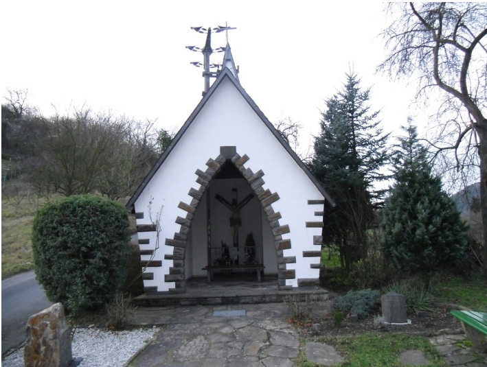
Die Kunnkapelle an der Kastellaunerstraße in Treis-Karden (2022) Fotograf/Urheber: Klaus Layendecker
