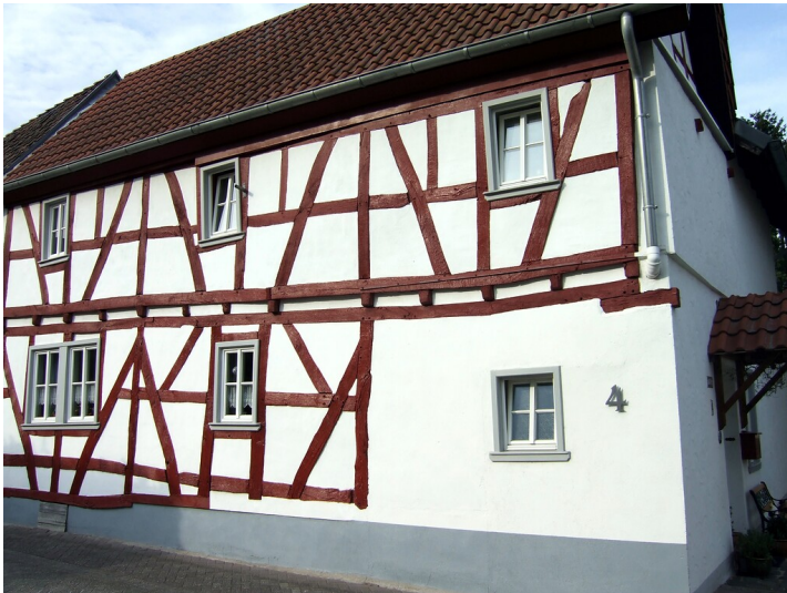
Fachwerkhaus Eulengasse 4 in Sinzig (2013) Fotograf/Urheber: Hans D. Jüchtern
