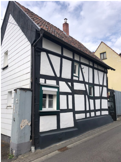
Fachwerkhaus Kirchgasse 7 in Sinzig (2023) Fotograf/Urheber: Elmar Knieps
