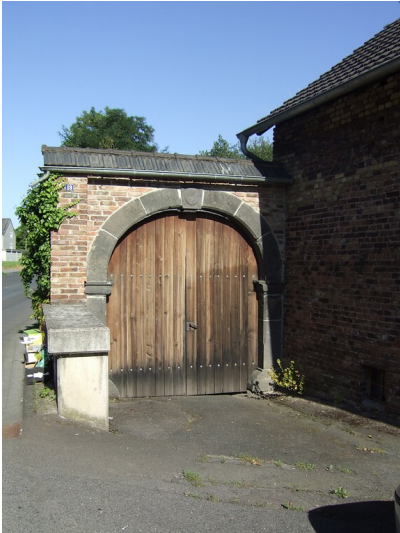
Torbogen der Schmitzmühle in Sinzig (2013) Fotograf/Urheber: Hans D. Jüchtern
