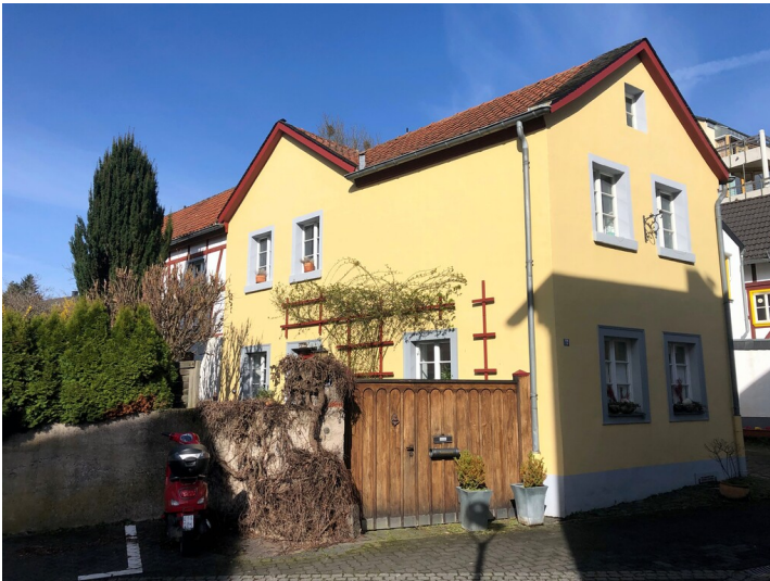
Fachwerkhaus Renngasse 17 in Sinzig (2023) Fotograf/Urheber: Elmar Knieps
