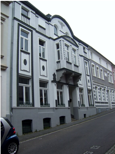
Wohnhaus Schlossstraße 4 in Sinzig (2013) Fotograf/Urheber: Hans D. Jüchtern
