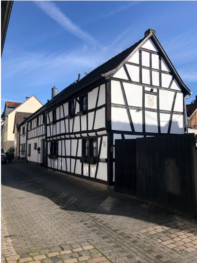
Fachwerkhaus Tuchergasse 14 in Sinzig (2023) Fotograf/Urheber: Elmar Knieps
