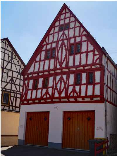
Das Fachwerkhaus in der Lahnstraße 8-10 in Dausenau (2022) Fotograf/Urheber: Gerd Jung
