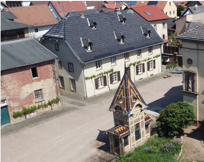
Der Neue Disibodenberger Hof gegenüber der Villa Puricelli-Plettenberg in der Großen Straße in Bretzenheim (2022) Fotograf/Urheber: Lukas Budde
