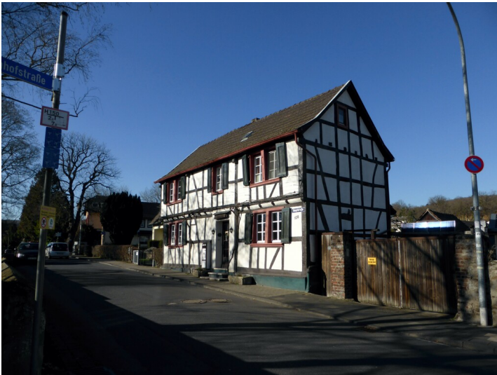
Fachwerkhaus Hauptstraße 128 in Sinzig-Bad Bodendorf (2023) Fotograf/Urheber: Elmar Knieps
