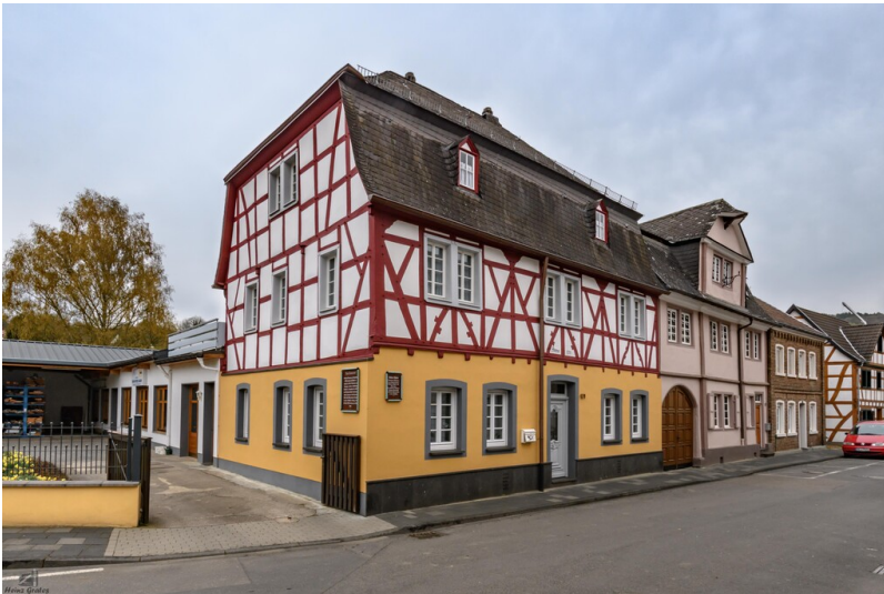
Fachwerkhaus Hauptstraße 124 in Sinzig-Bad Bodendorf (2018) Fotograf/Urheber: Heinz Grates
