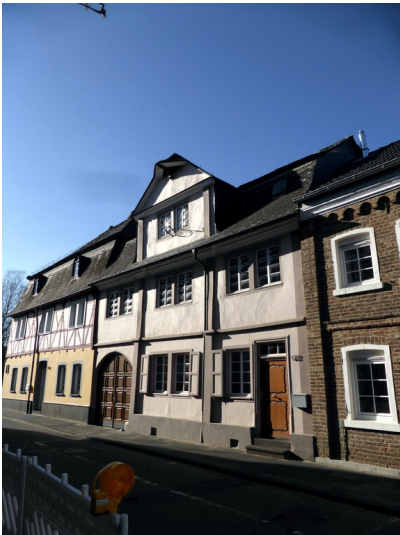
Wohnhaus Hauptstraße 122 in Sinzig-Bad Bodendorf (2023) Fotograf/Urheber: Elmar Knieps
