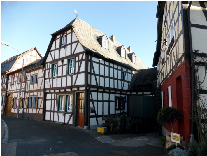
Fachwerkhaus Hauptstraße 91 in Sinzig-Bad Bodendorf (2023) Fotograf/Urheber: Elmar Knieps
