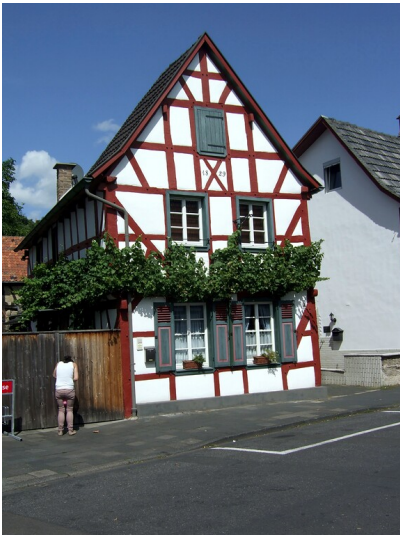
Fachwerkhaus Hauptstraße 86 in Sinzig-Bad Bodendorf (2013) Fotograf/Urheber: Hans D. Jüchtern
