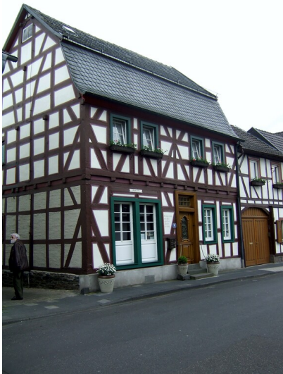
Fachwerkhaus Hauptstraße 85 in Sinzig-Bad Bodendorf (2012) Fotograf/Urheber: Hans D. Jüchtern
