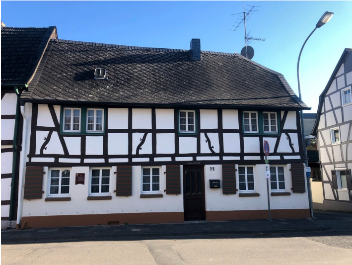
Fachwerkhaus Hauptstraße 75 in Bad Bodendorf (2023) Fotograf/Urheber: Elmar Knieps
