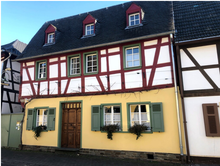
Fachwerkhaus Hauptstraße 69 in Bad Bodendorf (2023) Fotograf/Urheber: Elmar Knieps
