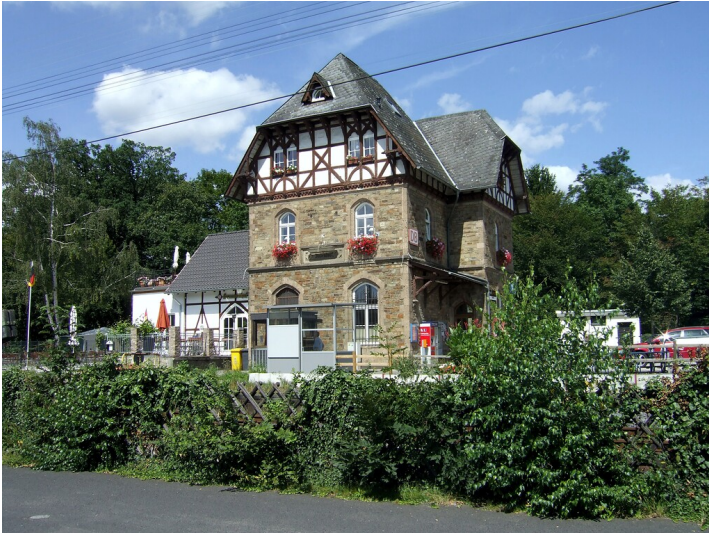
Bahnhofsgebäude in Sinzig-Bad Bodendorf (2013) Fotograf/Urheber: Hans D. Jüchtern
