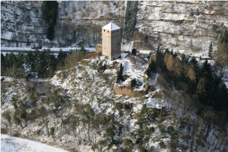
Ostansicht der Burg Treis (2022) Fotograf/Urheber: Markus Sausen
