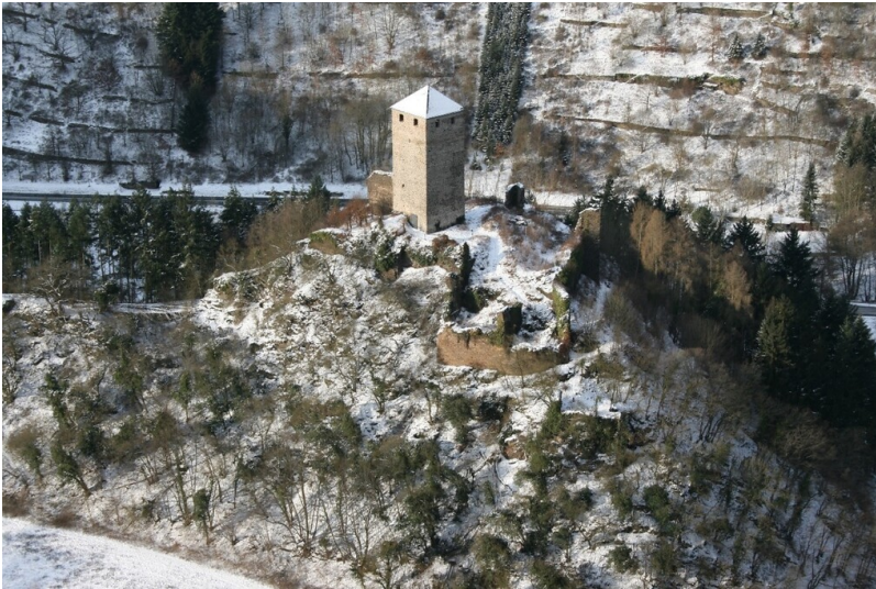
Ostansicht der Burg Treis (2022) Fotograf/Urheber: Markus Sausen
