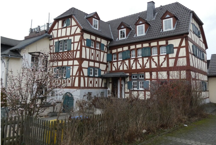
Zehnthof in Löhndorf (2022) Fotograf/Urheber: Matthias Röcke
