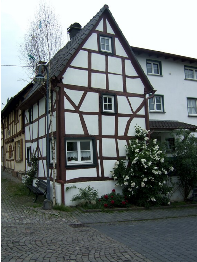
Fachwerkhaus Kreuzstraße 9 in Sinzig-Löhndorf (2012) Fotograf/Urheber: Hans D. Jüchtern
