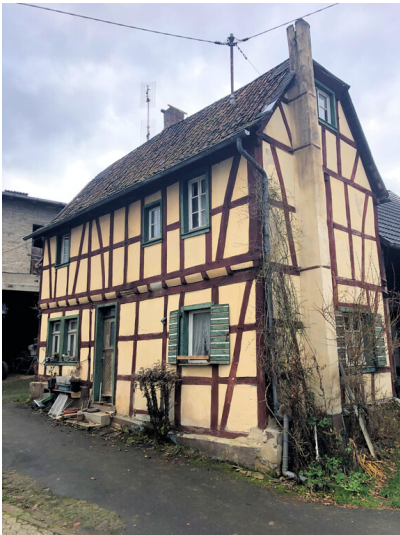
Fachwerkhaus Bachstraße 26 in Westum (2023) Fotograf/Urheber: Elmar Knieps
