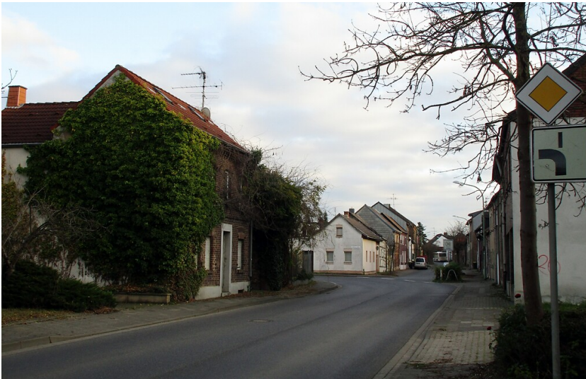
Blick in die verlassene Oberstraße von Morschenich, einem im Zuge des Braunkohle-Tagebau Hambach 2015 nach Morschenich-Neu umgesiedelten Ortsteil der Gemeinde Merzenich im Kreis Düren (2021). Fotograf/Urheber: Franz-Josef Knöchel
