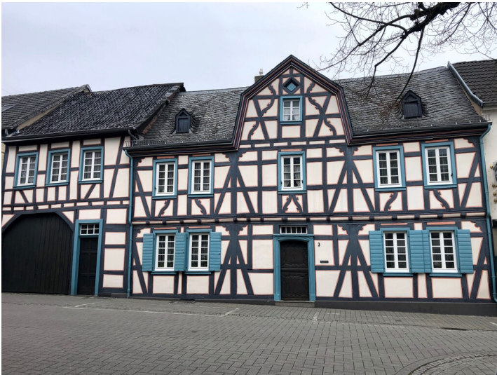
Fachwerkhaus Ausdorfer Straße 3 in Sinzig (2023) Fotograf/Urheber: Elmar Knieps
