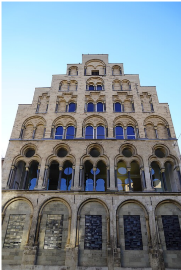
Die Frontansicht der Fassade des Overstolzenhauses in Köln (2023) Fotograf/Urheber: Ines Müller
