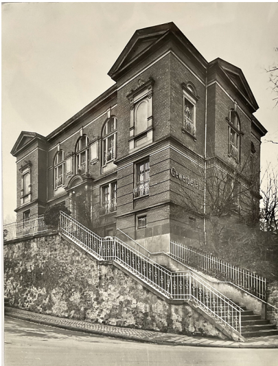
Historische Fotografie der Gewerbefhalle (um 1920) Fotograf/Urheber: unbekannt
