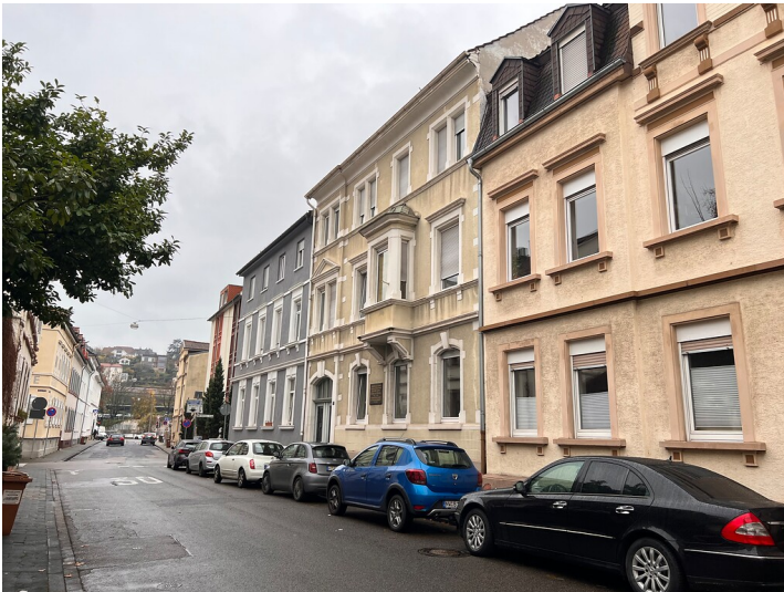
Wohnhaus Georg von Neumayer in Neustadt an der Weinstraße Fotograf/Urheber: Christine Brehm, SGD Süd
