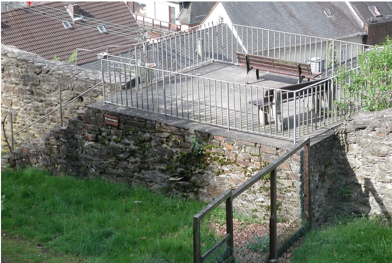
Dort, wo sich einst der Drehersturm als Teil der Stadtbefestigung in Dausenau erhob, befindet sich heute ein Aussichtspunkt (2010) Fotograf/Urheber: Gerd Jung
