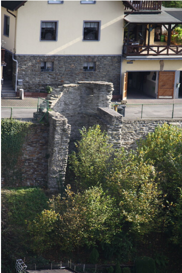
Der Rest des einstigen Christiansturmes in Dausenau (2016) Fotograf/Urheber: Gerhard Schäfer
