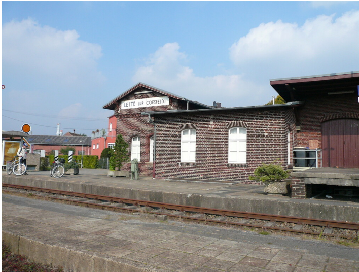
Der Museumsbahnhof Lette in Coesfeld von der Bahnsteigseite aus gesehen (2008) Fotograf/Urheber: Markus Schweiß
