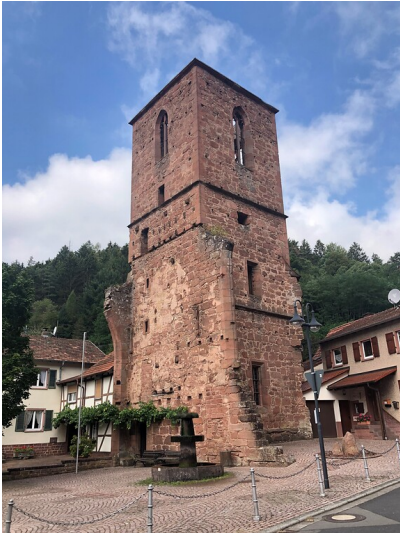
Alter Turm im Appenthal in Elmstein (2022) Fotograf/Urheber: Kreisverwaltung Bad Dürkheim
